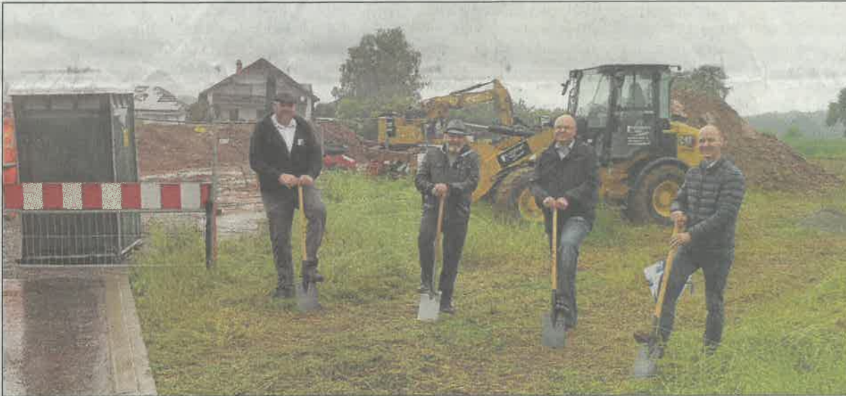
Bürgermeister Thorsten Weber (2.v.l.), Ortsvorsteher Werner Gellner und Vertreter der am Bau beteiligten Firmen gaben den Startschuss zur Erschließung der neuen Bauplätze. Foto: kö
