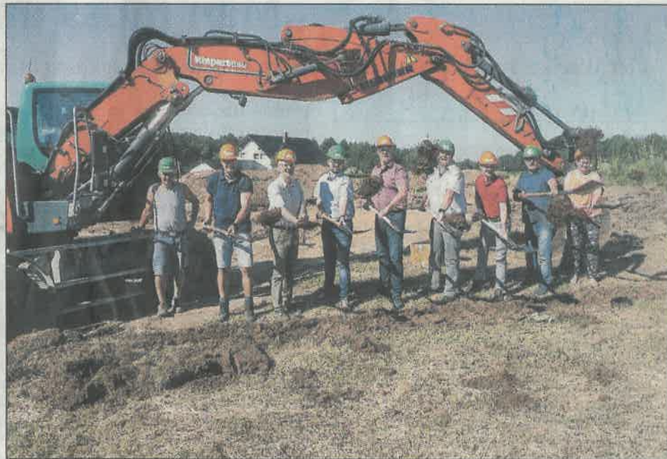
Der symbolische erste Spatenstich ist getan, nun kann die Erschließung des Baugebiets „Billäcker IV“ beginnen. Die Nachfrage nach den Bauplätzen ist hoch. Foto: Uwe Köbler
