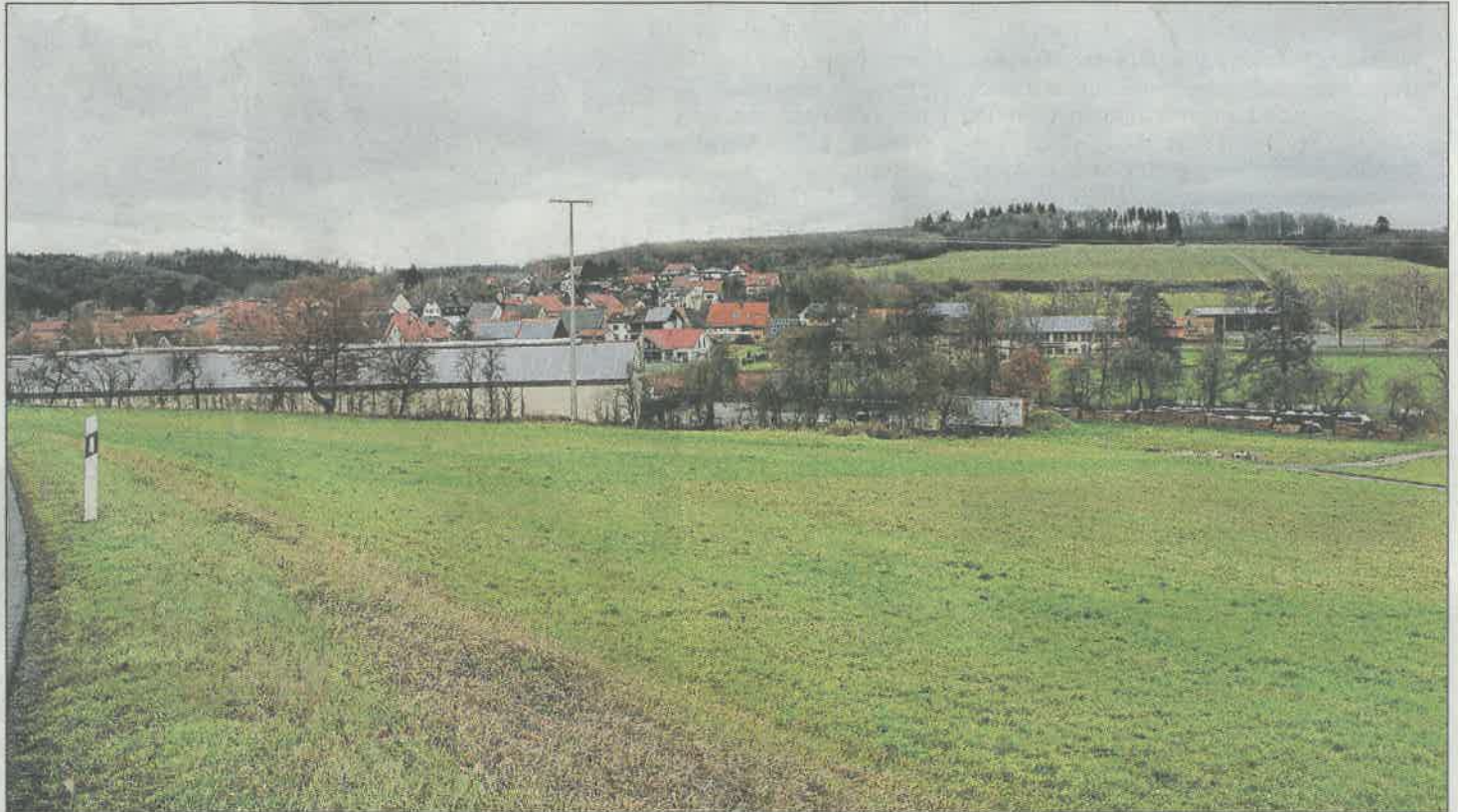
Auf dem Baugebiet „Mühlgärten“ in Sindolsheim will die Firma Vogt neue Gewerbehallen errichten. Foto: Helmut Frodl
